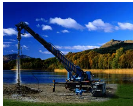
写真-1 施工状況
