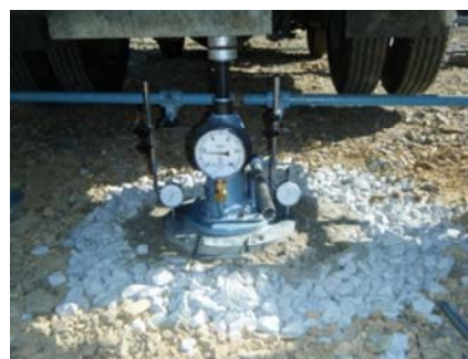
写真-2 平板載荷試験状況
